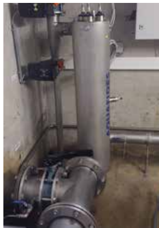
UV Anlage Innerlaterns
